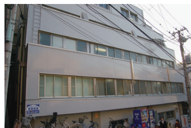
移転先の三洋ビル
